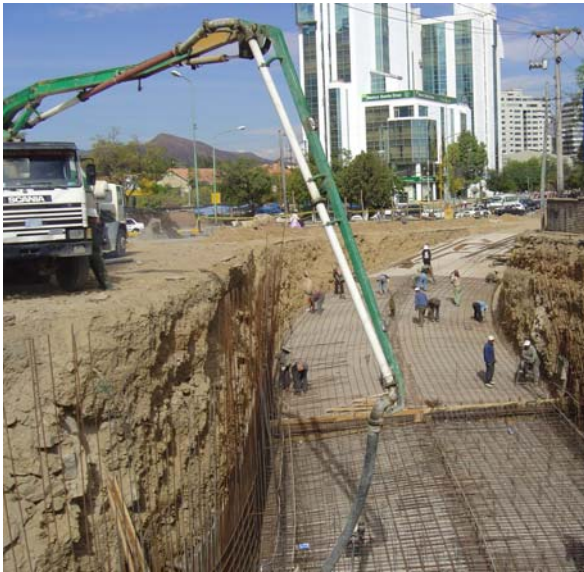
FIGURA 14.4. Camión Mixer descargando por bombeo el hormigón para un pavimento en el distribuidor de la Recoleta
