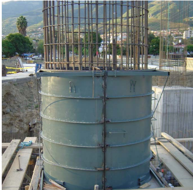
FIGURA 13.6 Encofrado de Pilar circular.
