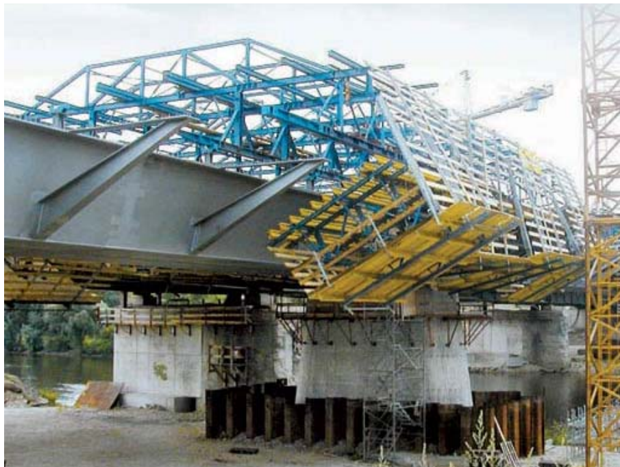
FIGURA 13.1 Encofrado Autoportante
