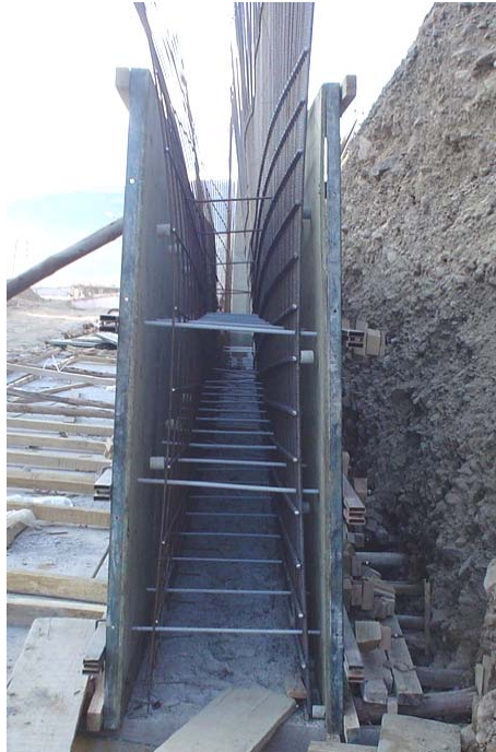
FIGURA 13.2 Encofrado de muro unido por tirantes
