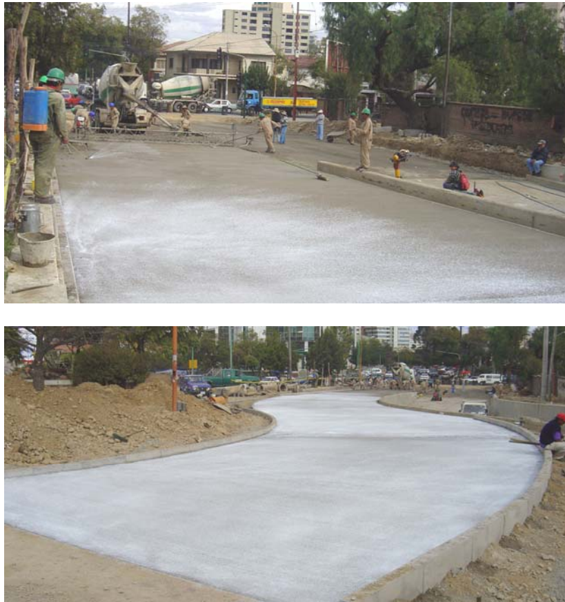
FIGURA 18.3 Aditivo formador de membrana de curado. Nótese el color blanco que deja el compuesto sobre el pavimento Distribuidor de la Recoleta Cochabamba.
