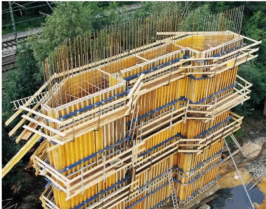
FIGURA 13.3 Encofrado pila de puente.
