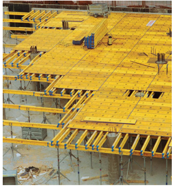
FIGURA 13.5 a) Encofrado de vigas de puente. b) Encofrado de losa.
