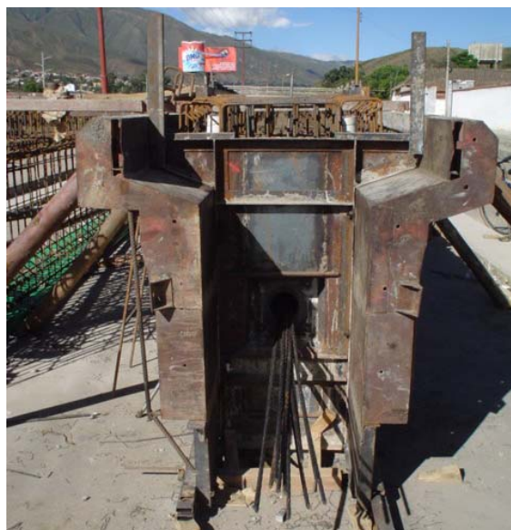
FIGURA 13.8 a) Encofrado de Viga preesforzada Distribuidor de la Muyurina - Cochabamba Fuente: Propia
