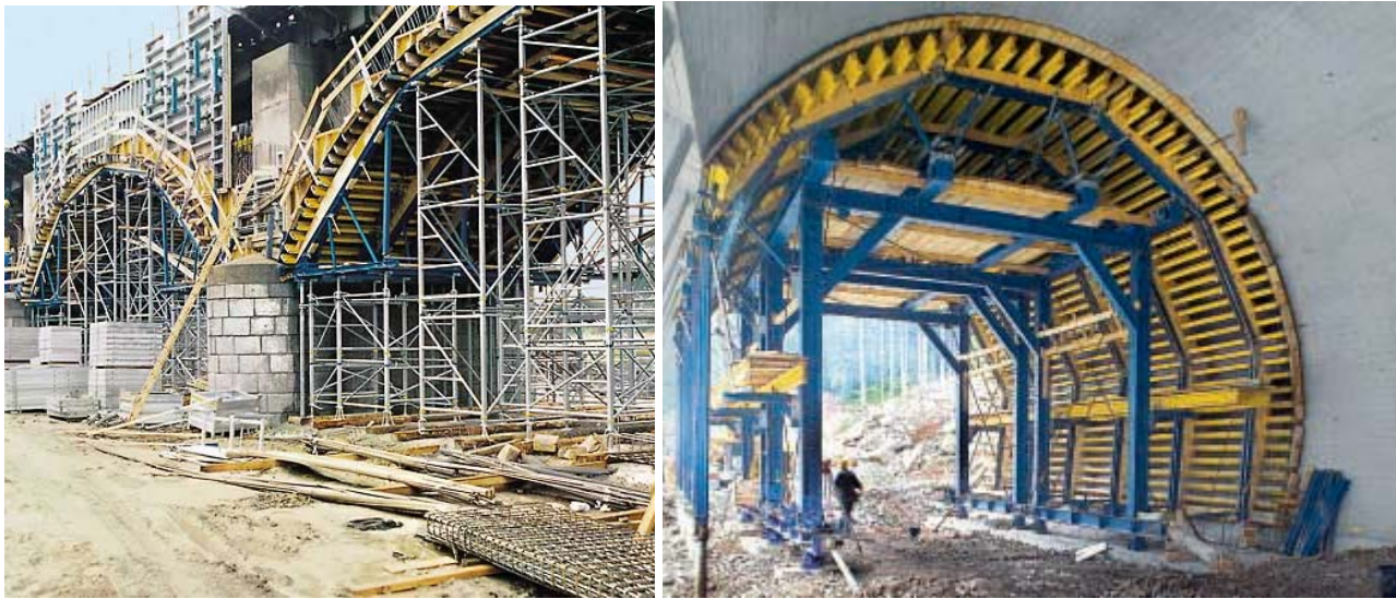
FIGURA 13.7 Encofrados de doble arco de curvatura (Cimbras y Matrices).
