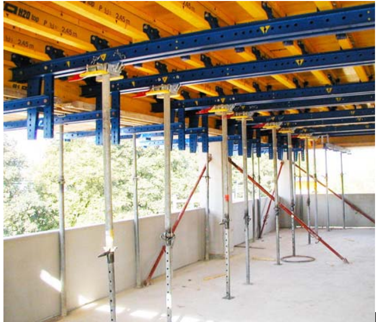
FIGURA 13.9 a) Puntales de madera b) Puntales metálicos. Distribuidor de la Muyurina - Cochabamba
