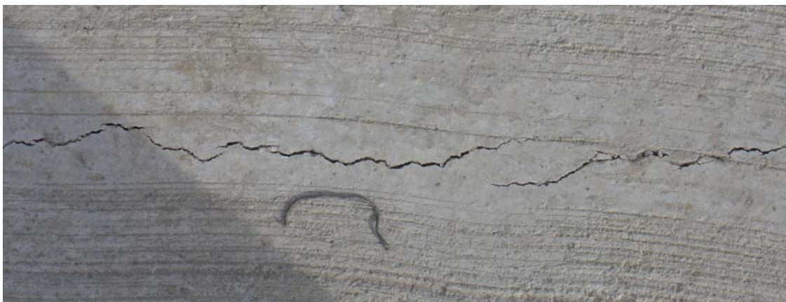
FIGURA 17.1 Grieta formada en una Losa de Hormigón.
