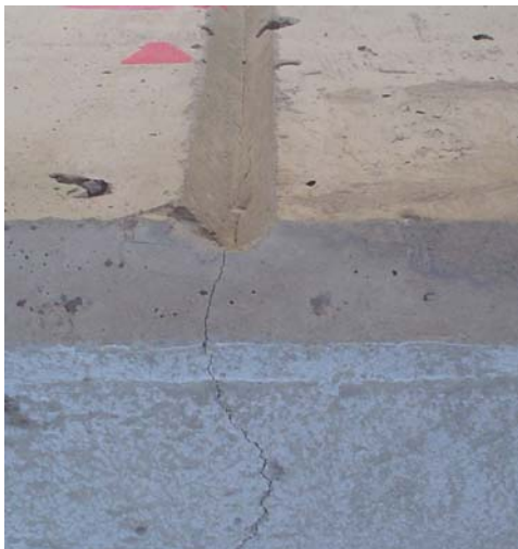
FIGURA 17.3 Grieta formada a lo largo del patrón de la junta. Nótese que la grieta sigue el plano de la junta.
