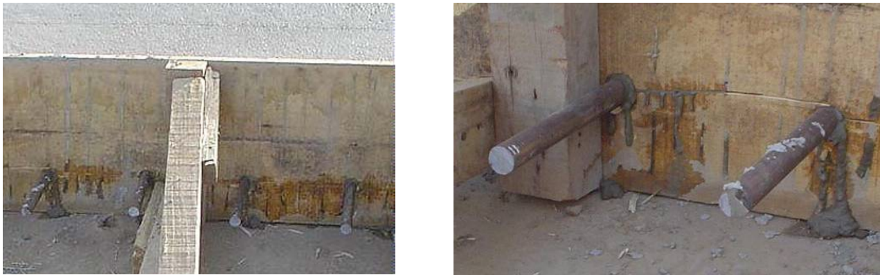
FIGURA 5.1 Pasadores de Juntas, en una losa de pavimento rígido.
