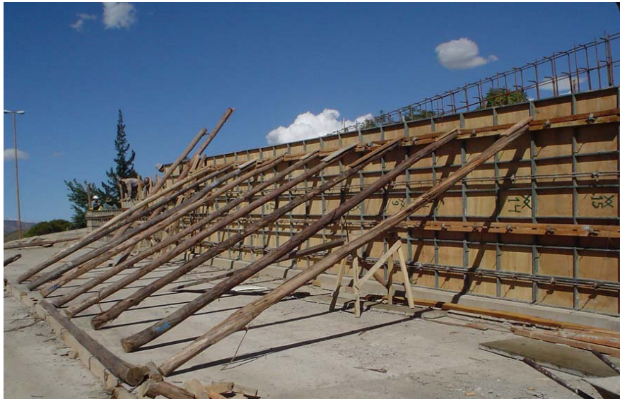
FIGURA 13.11 a) Arriostramiento diagonal.
