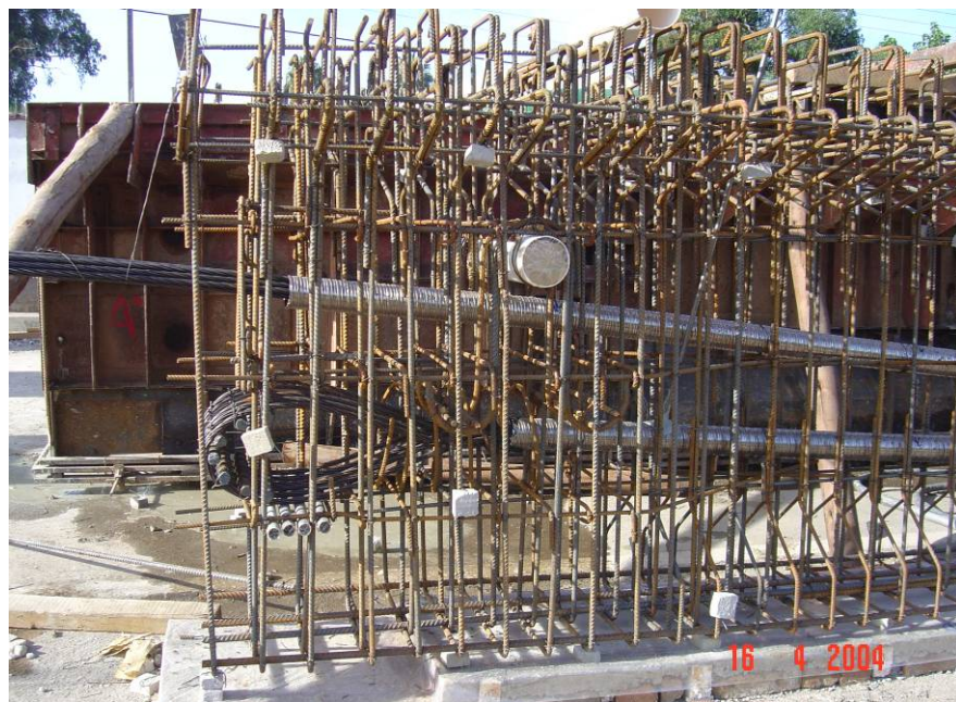
FIGURA 5.8 Vaina para postensado, embebidas en una viga, antes del vaciado
