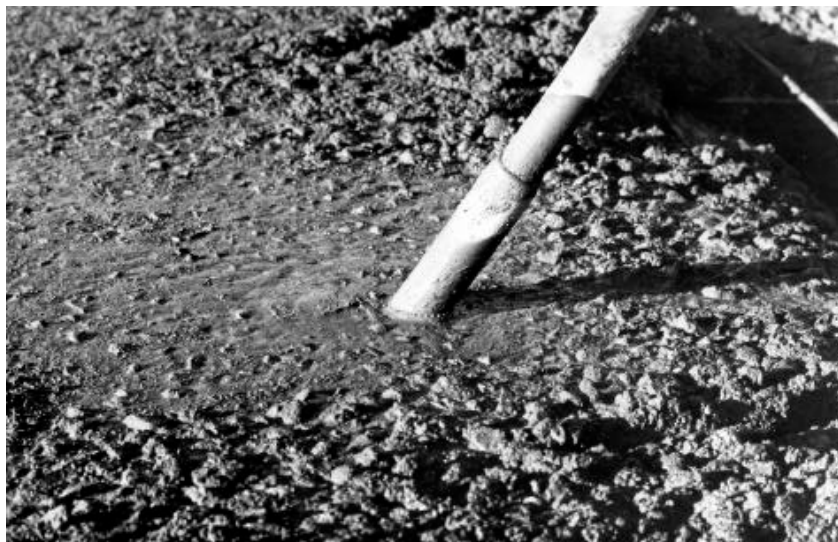
FIGURA 16.2. Vibrador interno liquidificando hormigón de bajo revenimiento Fuente Referencia 2
