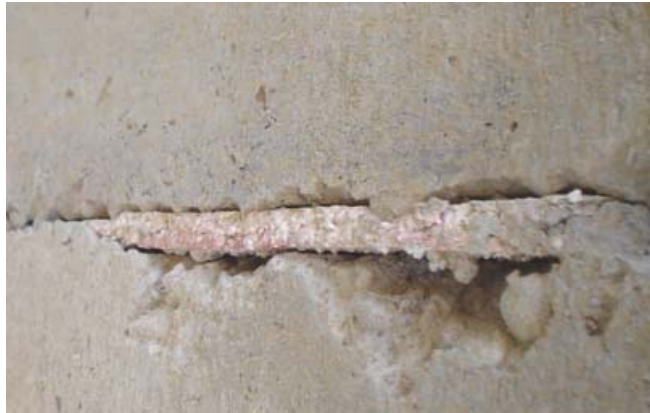
FIGURA 17.18 Plastoformo en juntas de dilatación. Distribuidor de la Recoleta, Cochabamba
