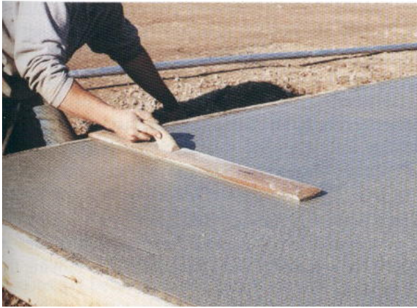
FIGURA 16.7. Frotachado manual.
