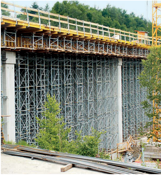
FIGURA 13.5 a) Encofrado de vigas de puente. b) Encofrado de losa.
