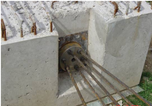
FIGURA 5.7 Vigas postensadas
