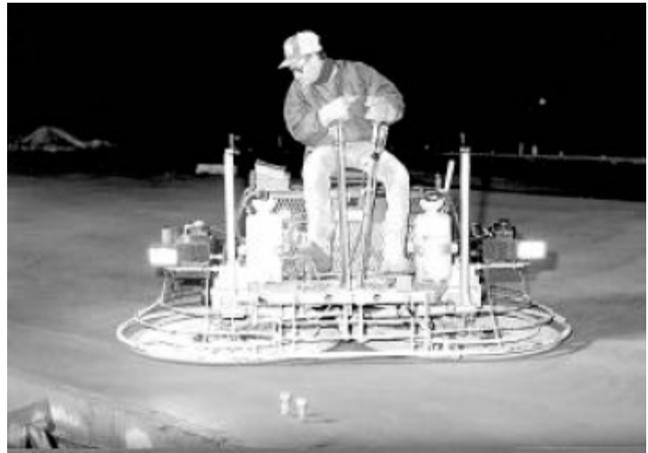
FIGURA 16.8. Frotachado mecanizado con una maquina rotatoria doble
