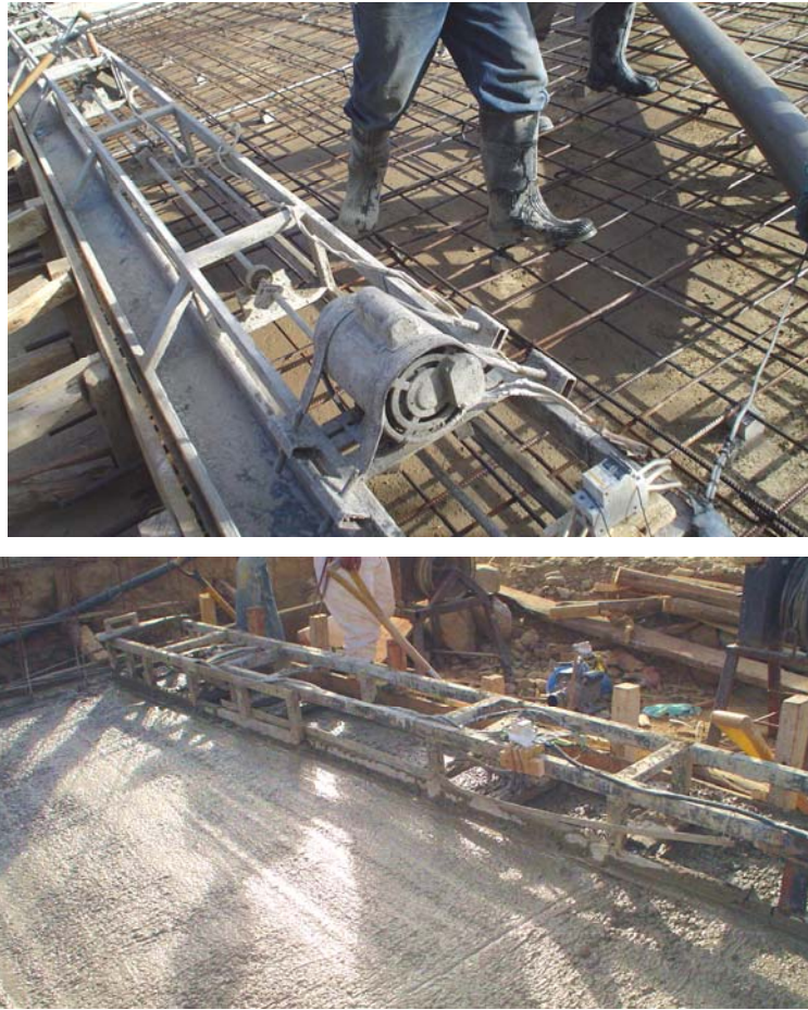
FIGURA 16.3. Reglas vibratorias
