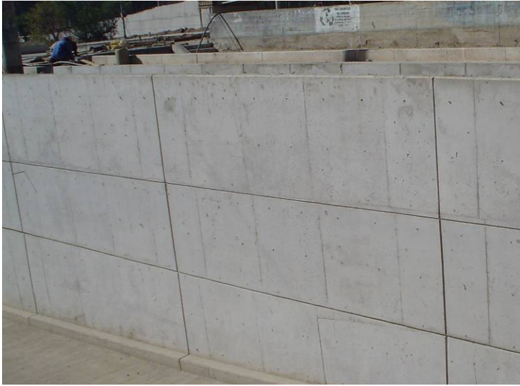
FIGURA 17.5 Juntas de Contracción en un muro de contención.
