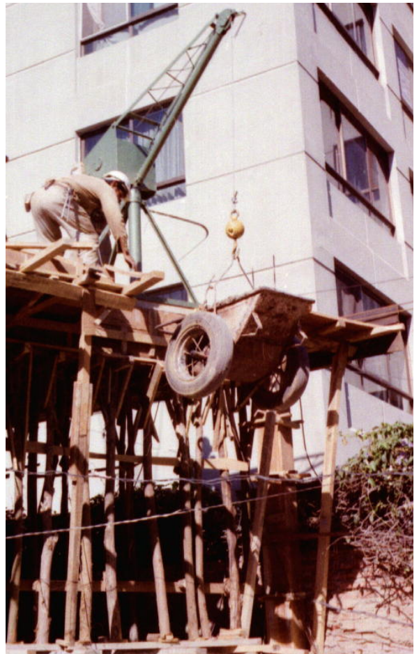
FIGURA 14.6. Guinche elevando carretón con hormigón
