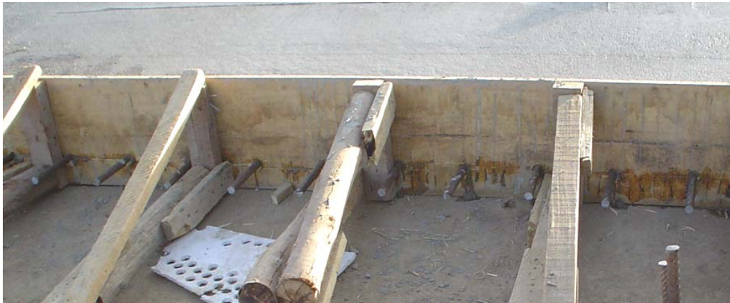
FIGURA 17.9 Barras de acero para transferencia de carga en una losa de calzada del distribuidor vehicular de la Muyurina.
