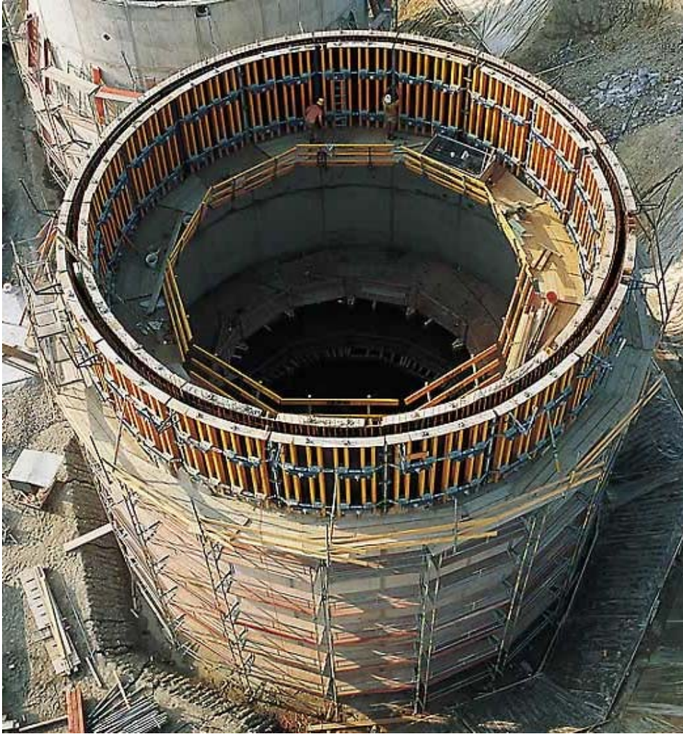
FIGURA 13.4 Encofrado de silo.
