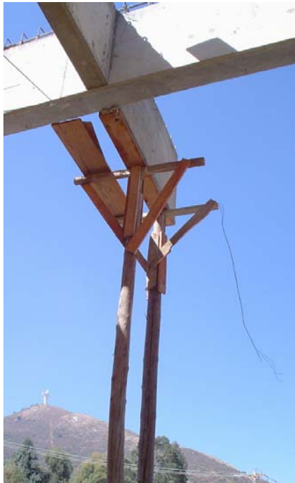
FIGURA 13.9 a) Puntales de madera b) Puntales metálicos. Distribuidor de la Muyurina - Cochabamba
