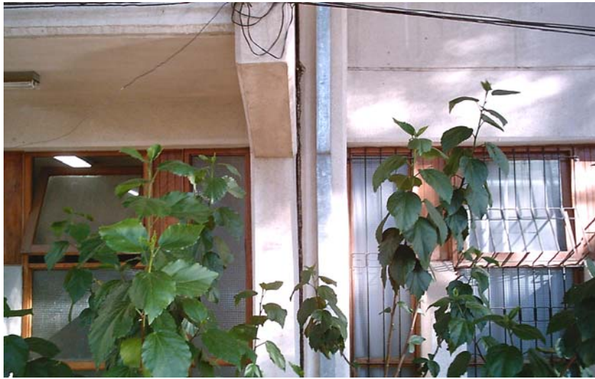
FIGURA 17.6 Junta de Dilatación. Edificio Multifuncional U.M.S.S.
