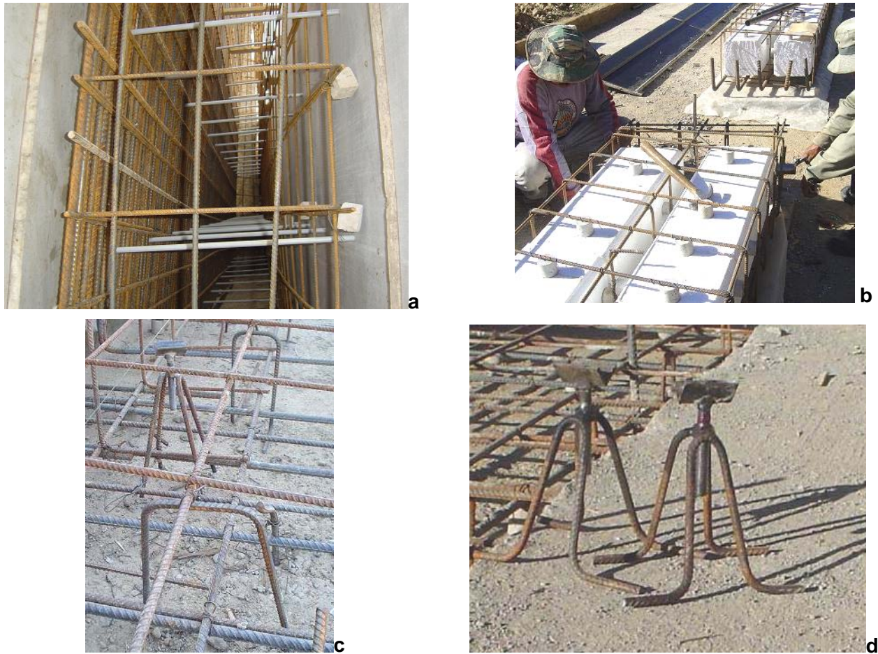
FIGURA 15.3. a) galletas para mantener el encofrado a la distancia especificada de recubrimiento, b) galletas para mantener la armadura en su posición en una viga cajón, c) caballetes para mantener la armadura en su posición, en una losa, durante la puesta en obra, y d) caballetes utilizados par mantener las guías de la regla vibratoria durante el vaciado, y acabado.
