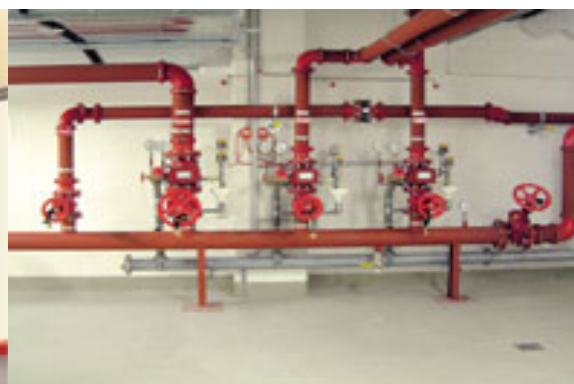
Fig.A.62. Instalaciones de rociadores automáticos. [62]
