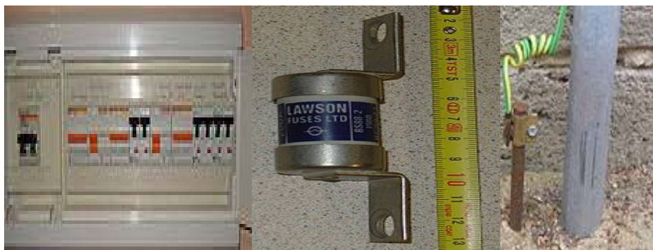
Fig.A.55. Cuadro eléctrico. [60] Fig.A.56 Fusible industrial. [60] Fig.A.57. Toma a tierra. [60]
