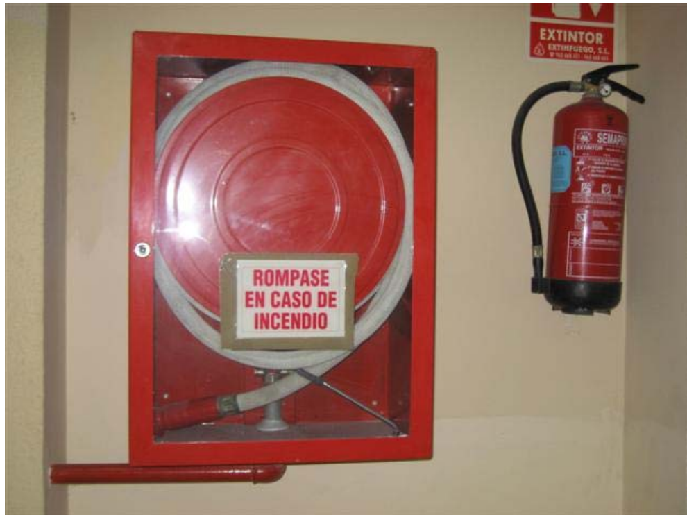
Foto 6.7 Bocas de Incendio y Extinguidor
