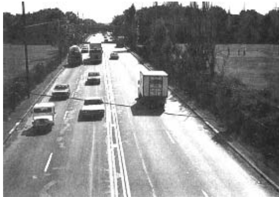
Figura N° 5.41 Hombreras inadecuadas y obstrucciones en la carretera
