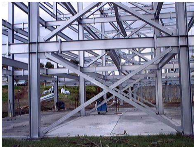
En este grafico se muestra una estructura metálica aporticada
