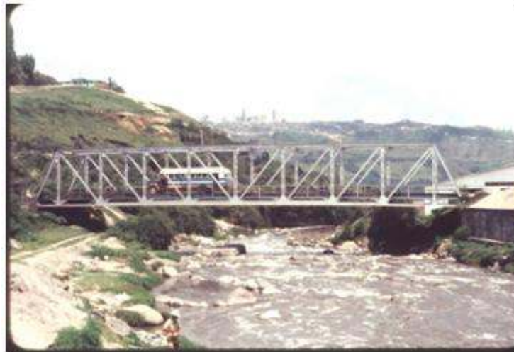
En este grafico se muestra un puente de armadura metálica tipo Pratt plana
