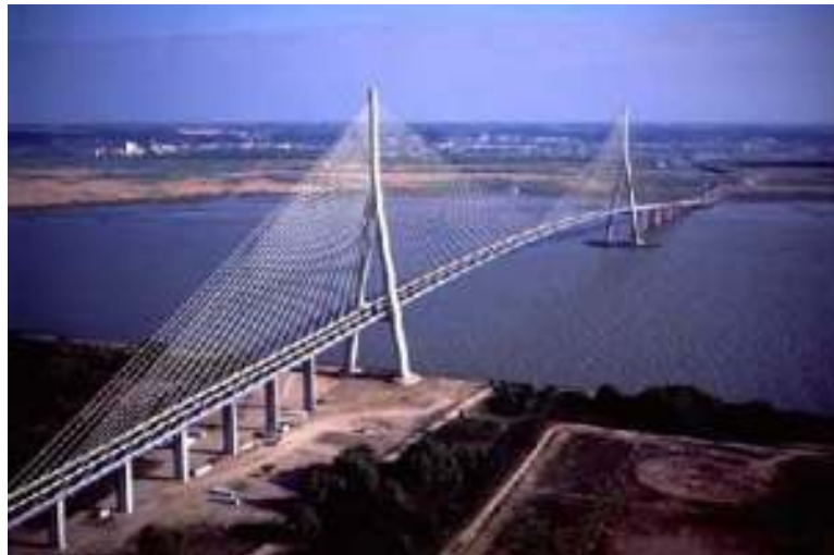
En este grafico se muestra un puente atirantado de vial.
