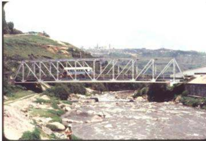
Figura 4.7 Puente de cerchas vehicular, tablero inferior
