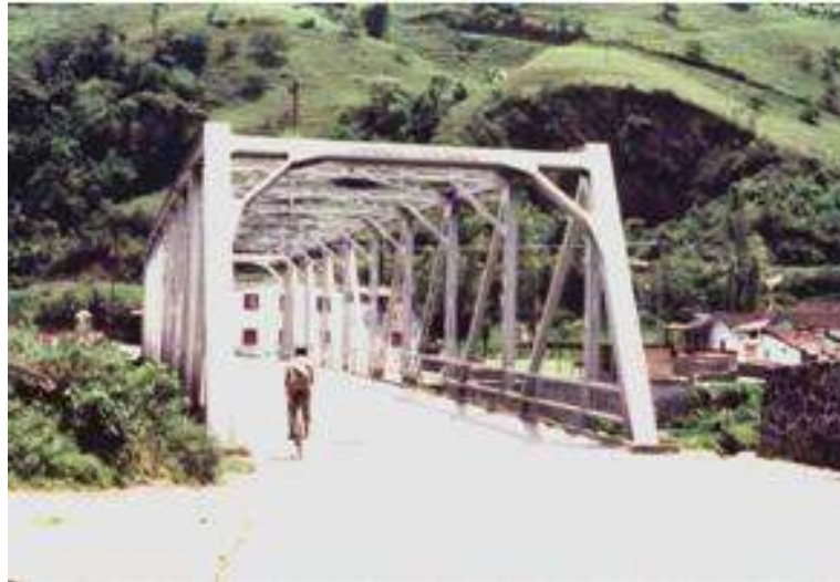
Figura 4.8 estabilización lateral de las cerchas de tablero inferior
