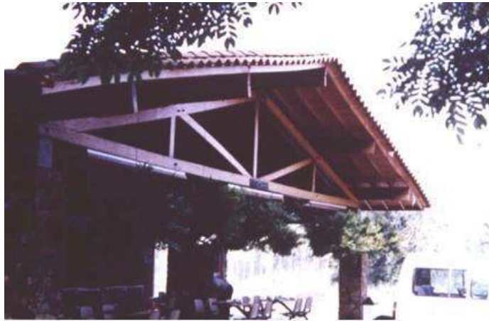
Figura 4.4 Cercha tipo pendolón en el plano
