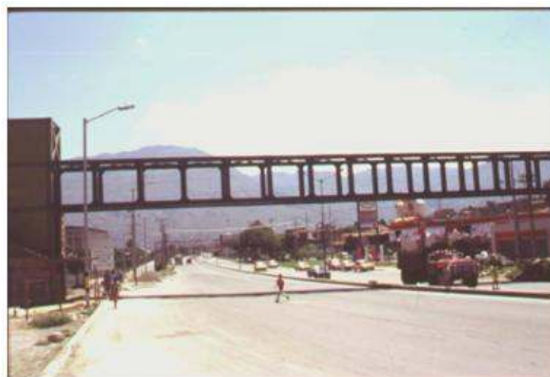
Figura 4.9 Viga Vierendel de acero usada en puente peatonal
