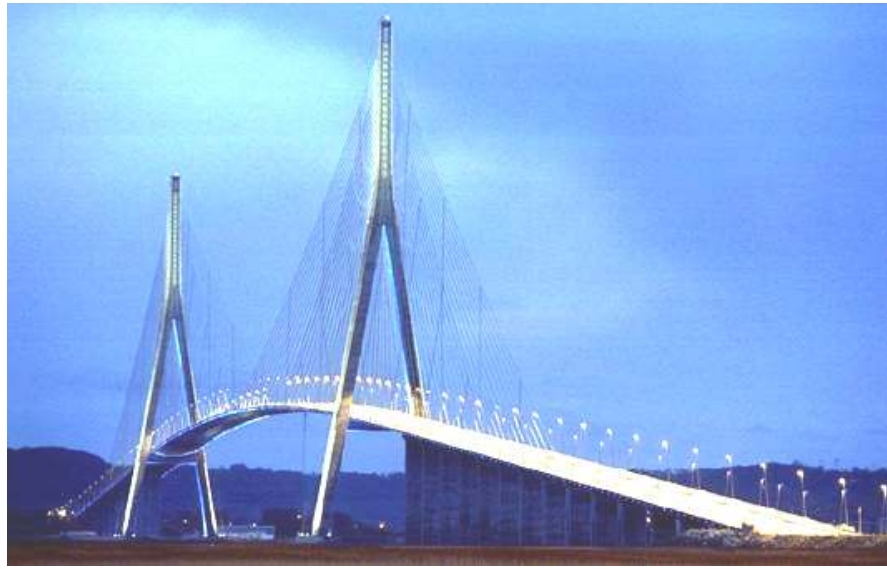
Puente de Normandia, muestra cables ajustados directamente a la trabe
