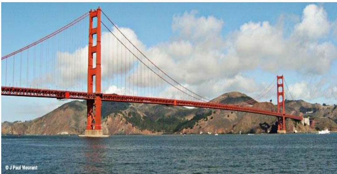
Puente de San Francisco, muestra cables con colgantes fijos a la trabe
