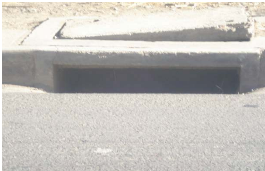
Figura: 8.6.- Grafica de un sumidero tipo ventana o acera
