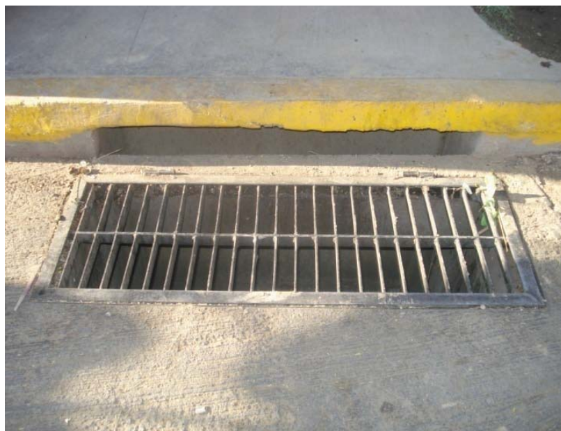
Figura 8.8.- Grafica de un sumidero combinado
