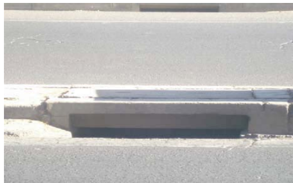
Figura 6.3: Grafica de un sumidero tipo ventana
