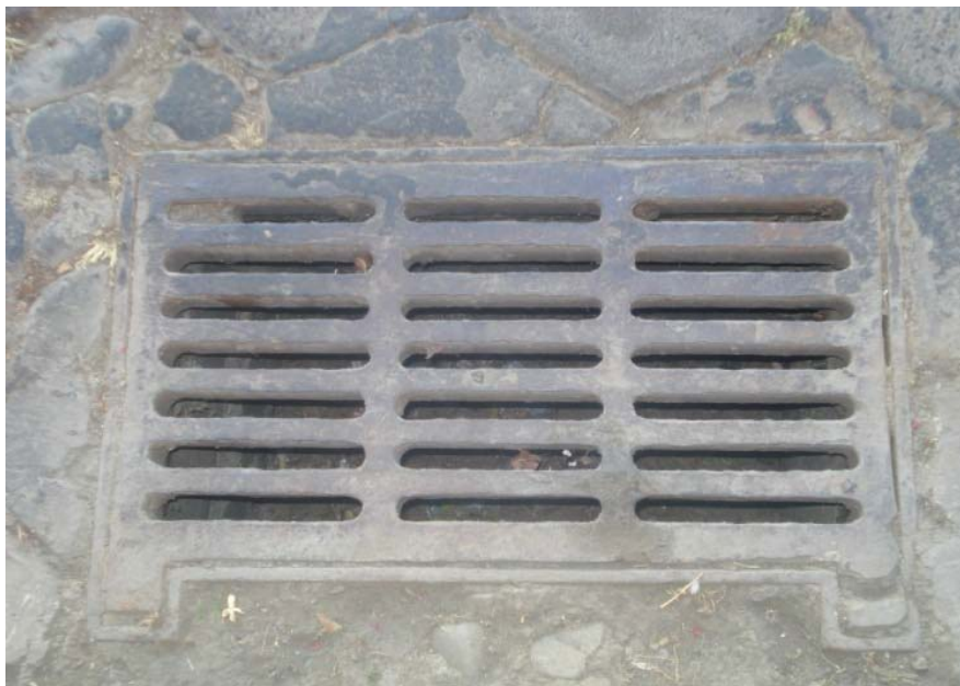
Figura 8.7.- Grafica de un sumidero tipo reja o calzada
