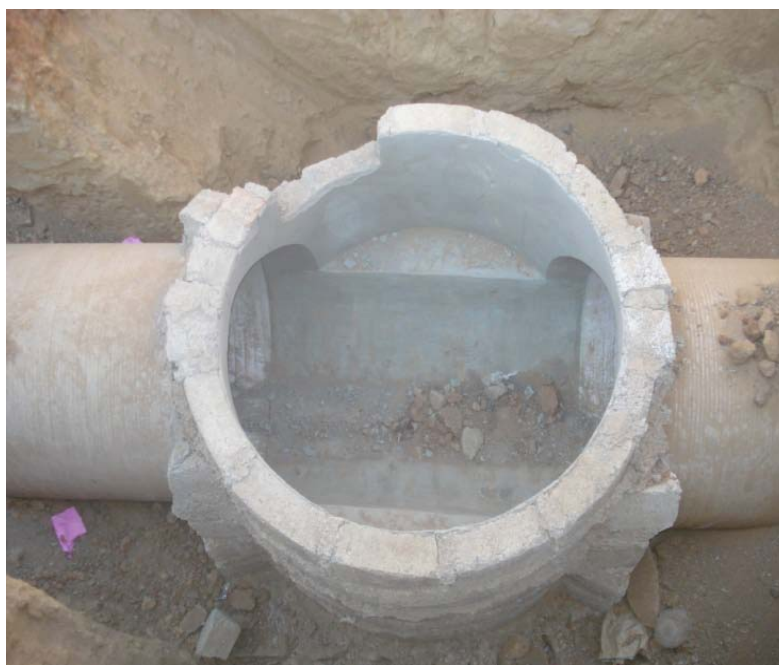
Figura 8.4.- Construcción de cámara de inspección
