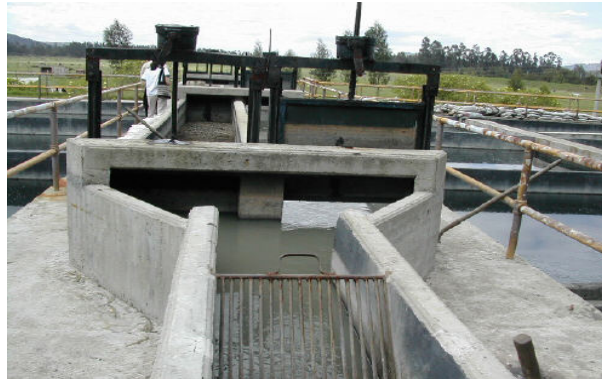
Fotografia 4.1 Rejilla fija con limpieza manual
