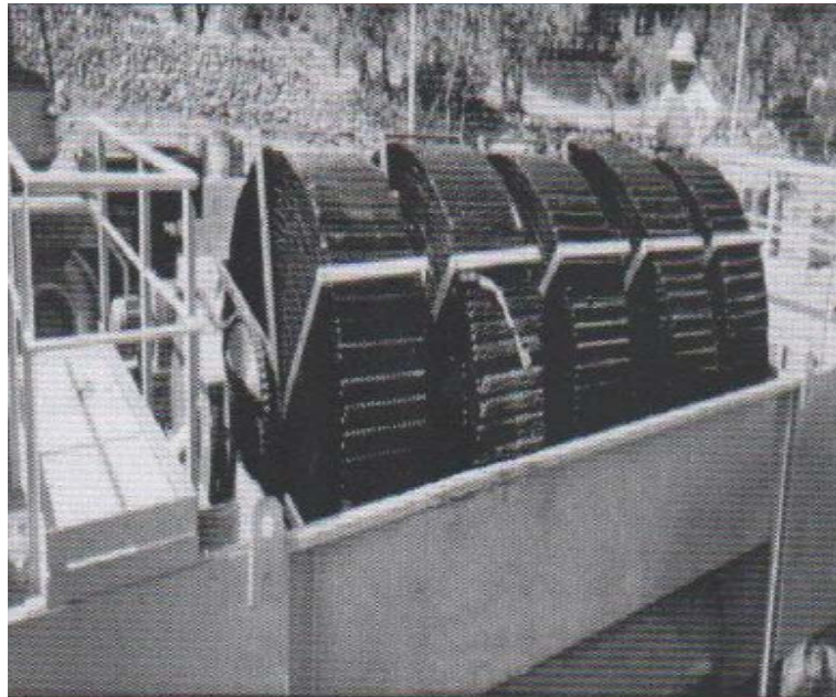
Fotografia 1.4 Vista general de un Biodisco
