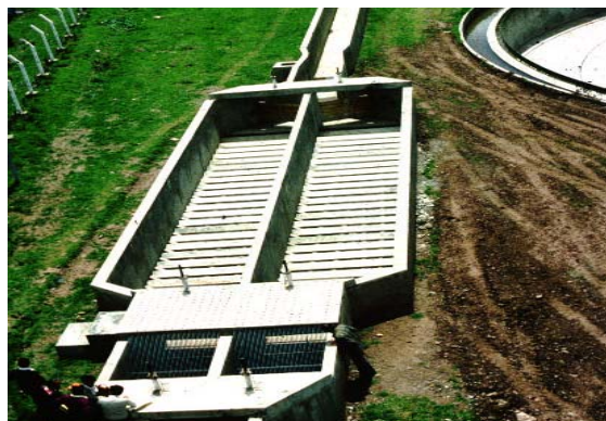
Fotografia 4.3 Desarenadores de flujo horizontal en paralelo
