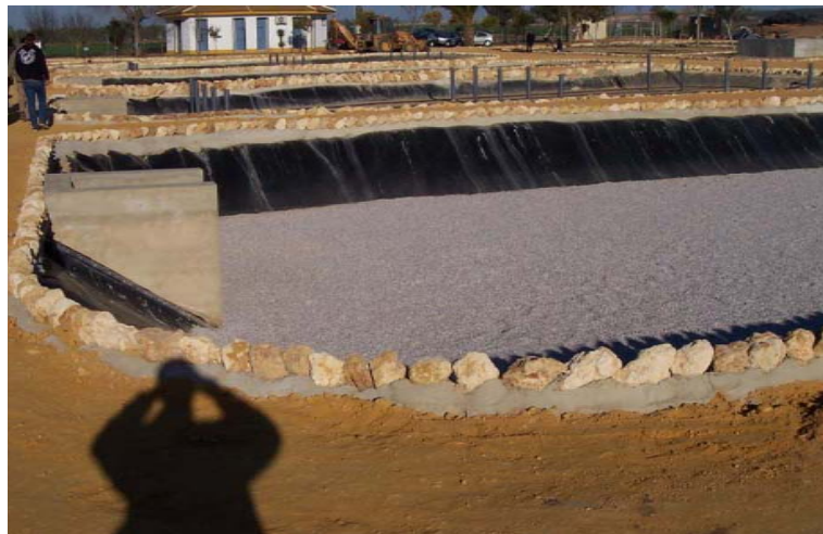
Fotografía 6.4 Revestimiento de una laguna de estabilización con polietileno
