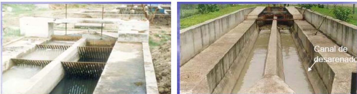
Fotografía 1.1 Canal de rejas a la izquierda y canal desarenador a la derecha
